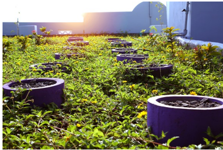
Auf dem Dach der Green Factory in Tiruppur/Südindien
