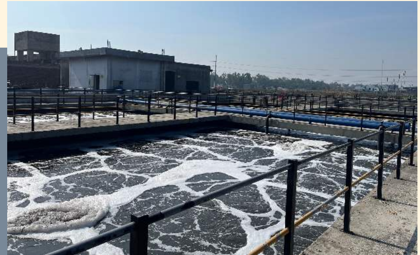
Abbildung: Abwasserbehandlung bei einem Zulieferer von BRANDS Fashion
